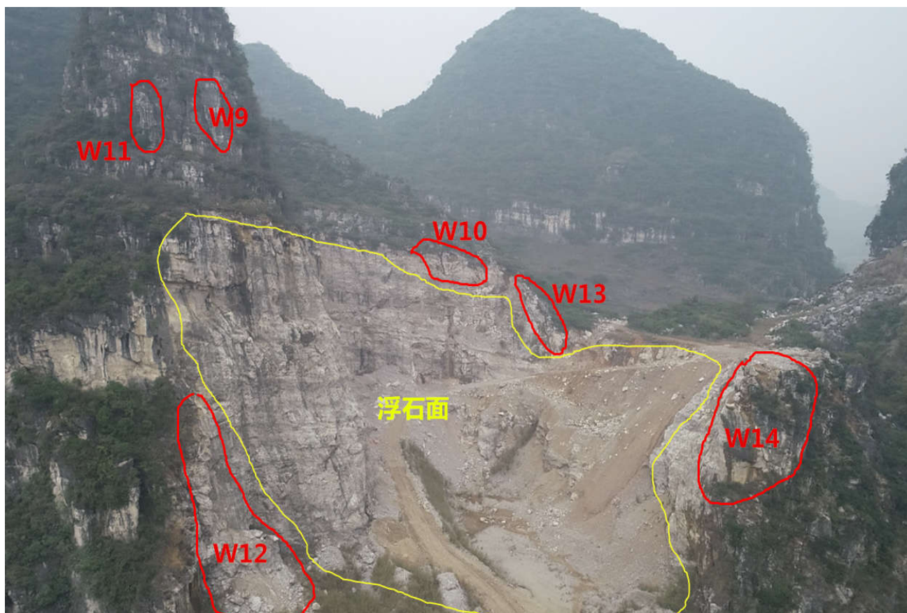
照片3 原I号矿区南西侧开采面危岩点分布相片
