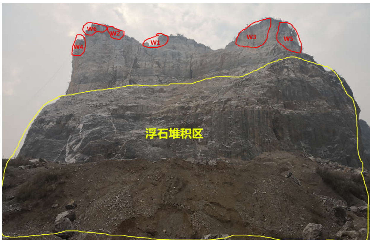
照片 1 原 II 号矿区开采面危岩点分布相片
