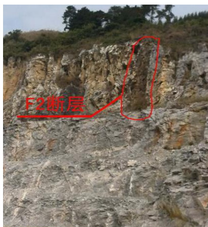
照 2-1 F2 断层出露断面
