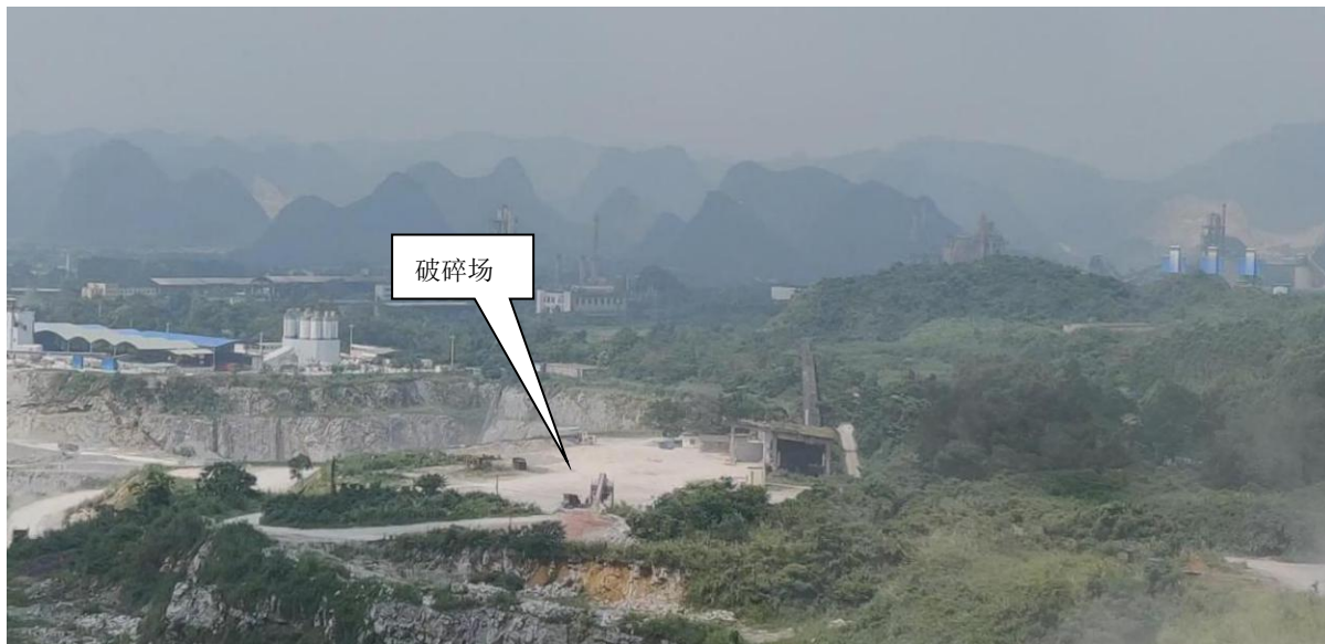
照片 10 破碎场（镜向 S）
