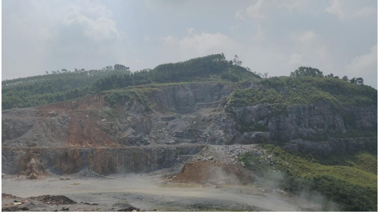
照片 6 现状露天采场北部边坡(镜向 E)
