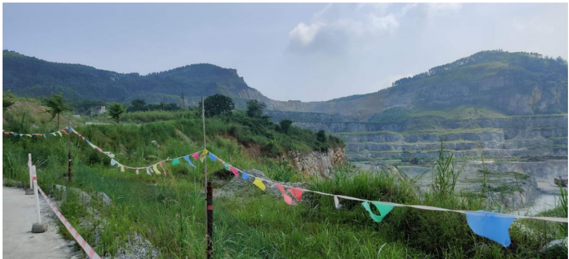
照片 17 露天采场外北侧边坡植被恢复情况
