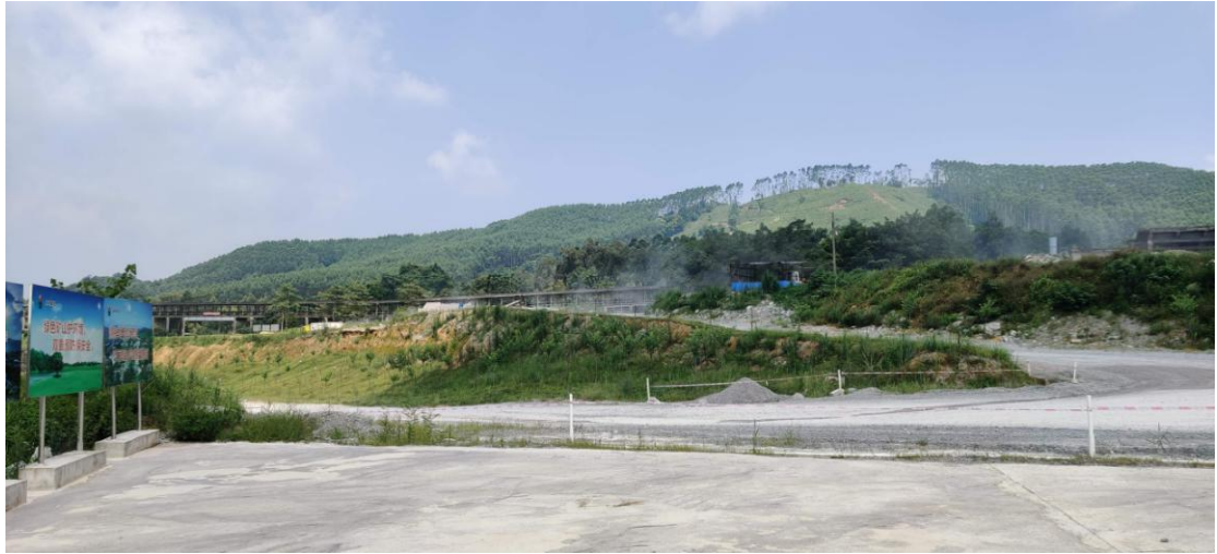
照片 15 露天采场外西侧边坡植被恢复情况
