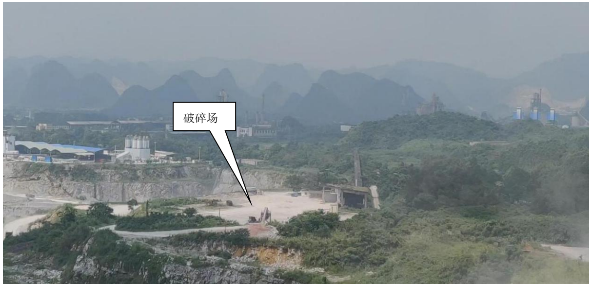
照片 10 破碎场（镜向 S）
