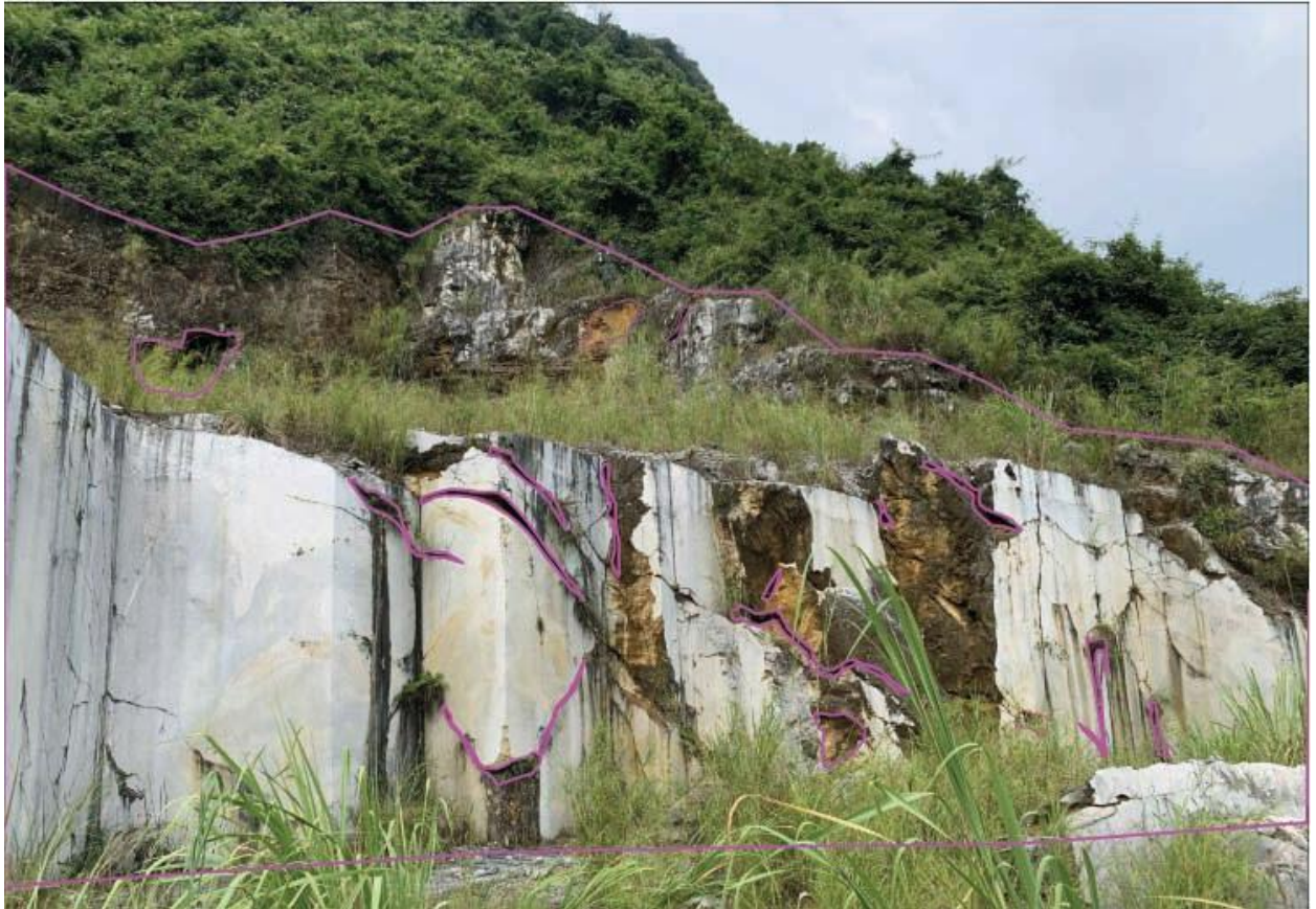
图 3.2-2 老席山矿区岩溶统计素描面（ C_2h^3 ，生物碎屑灰岩，YRTJ-P1 红色为岩溶发育区）
