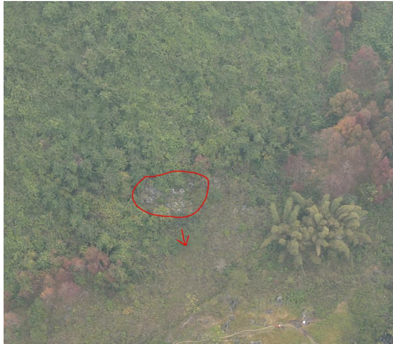
照片 5-1-1 危岩（俯视图）
