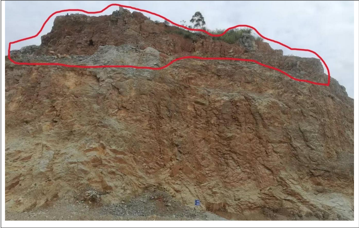
照片 5.1-1 北部边坡危岩群分布图（镜头方向：340 度）
