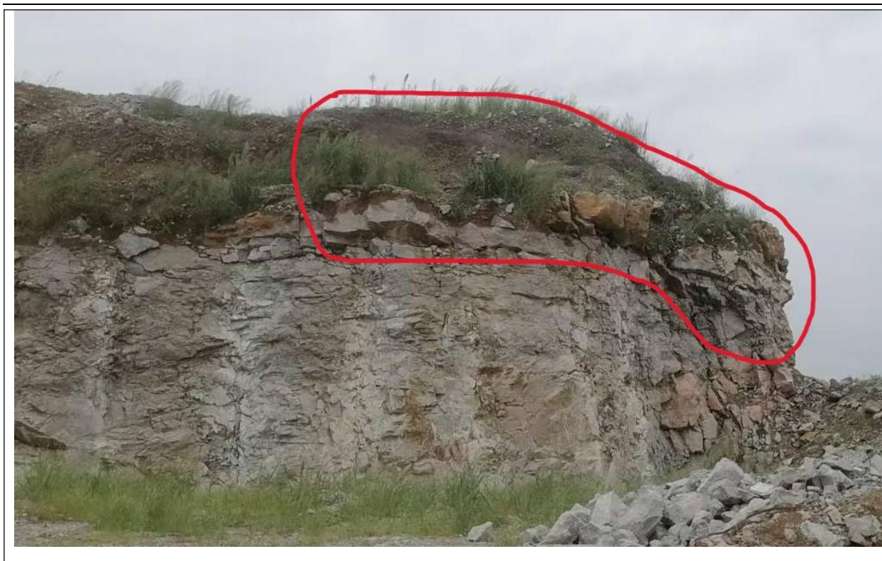
照片 5.1-3 西南部边坡危岩群分布图 镜头方向：270 度
