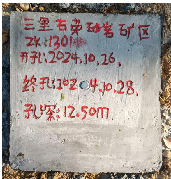
相片 3-20 钻孔封孔
