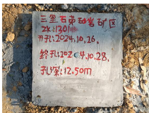
相片 3-23 钻孔封孔水泥桩
