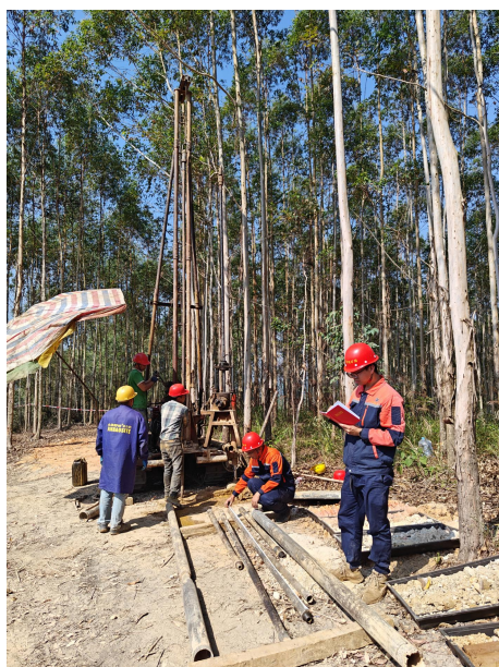
相片 3-19 钻孔孔深校正
