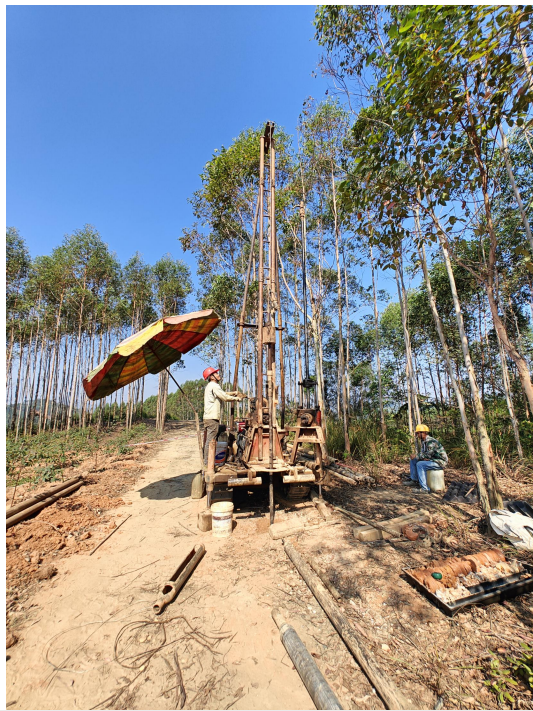
相片 3-21 钻机施工现场 (ZK904)
