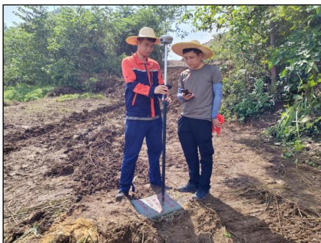
图 3-13 钻孔工程点测量
