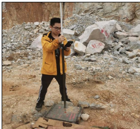
照片 3-6-1 已完工的钻孔定位测量
