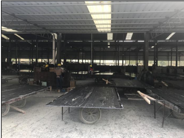
照片 3-4-2 板材抛光过程
